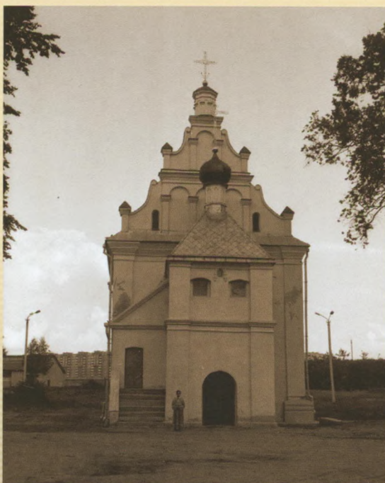
Сёння мясцовасць Куцейна ўжо ўваходзіць ў межы Воршы...: Святадухаўская царква на фоне гарадской забудовы. Здымак 1995 г.
