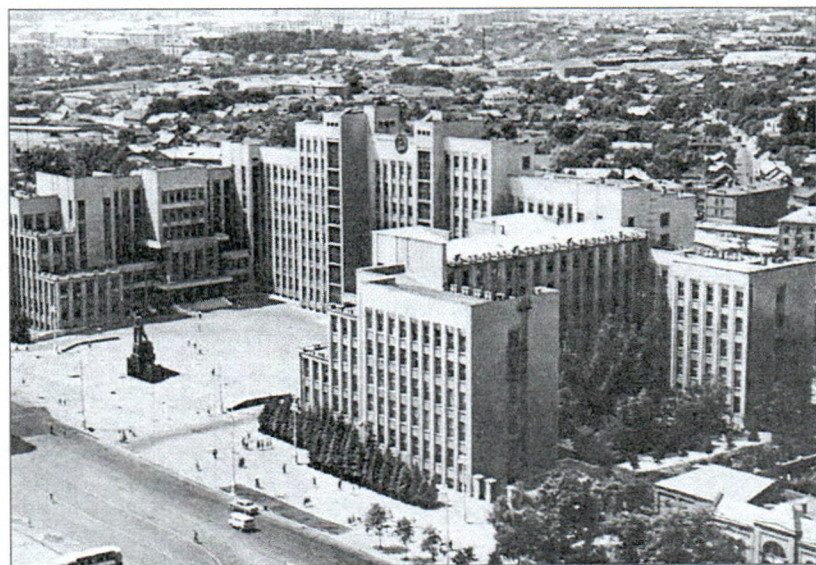
Ілюстрацыя 13. Дом урада паводле праекта І. Р. Лангбарда на плошчы Леніна (1930–1934 гг.)
