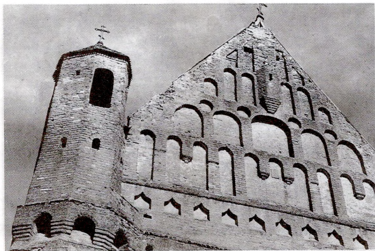
Сынкавічы. Царква. Галоўны фасад
