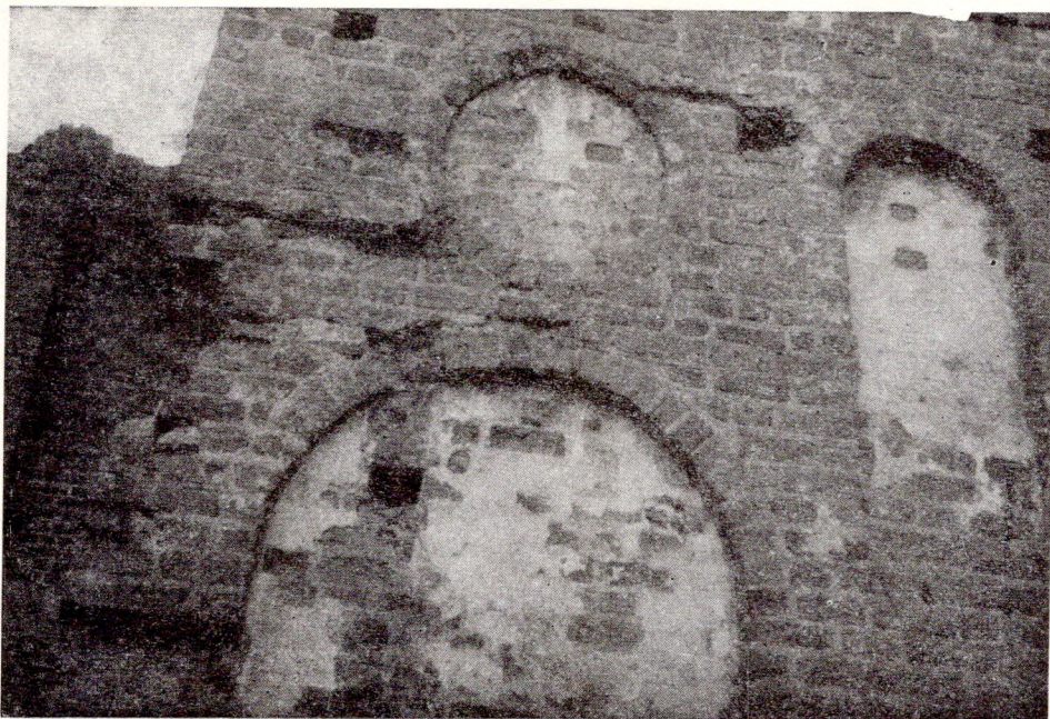
Мал. 97. Замак. Круглая дэкаратыўная ніша на вежы-браме выкладзена з профільнай цэглы 16 ст.
