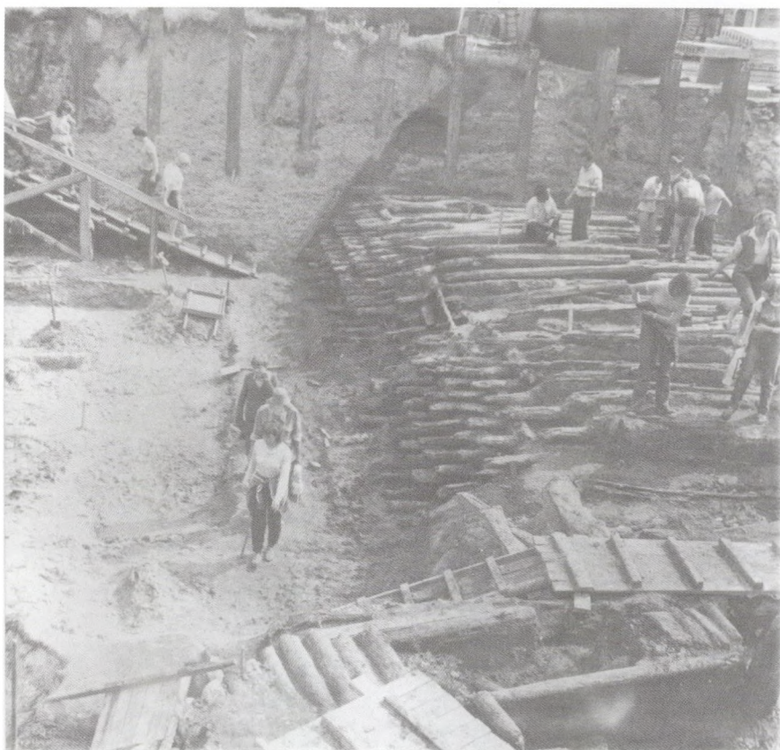
Бярвёны, якія складалі ўнутраную канструкцыю вала Менскага замчышча, раскопкі 1984–1985 гадоў
