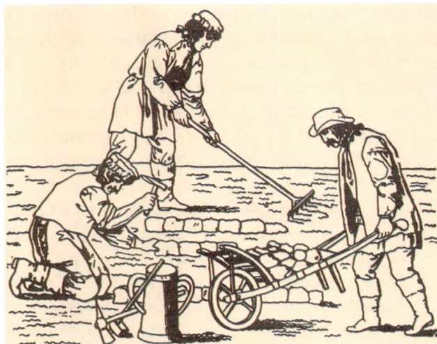
Будаўніцтва шашэйнай дарогі
