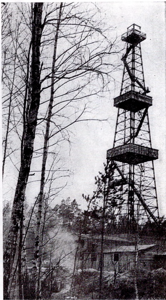
Une des premières installations de forage dans la Pologne
