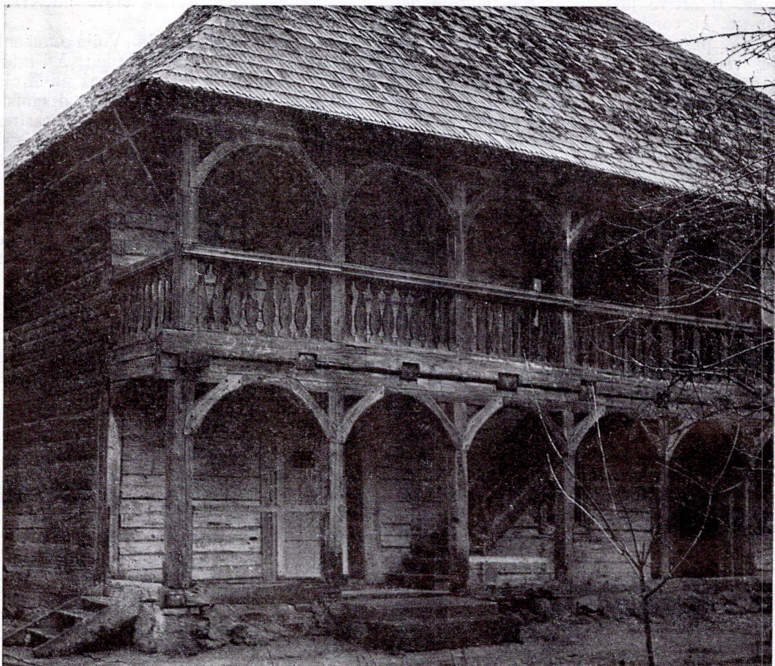
Grodno. Dans la cour du monastère, un bâtiment servant d'entrepôt et d'habitation
