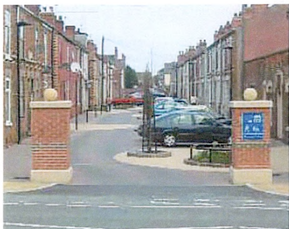
Мал. 15. Уезд у woonerf: прыўзняты пешаходны пераход, звужэнне і адхіленне траекторыі праезнай часткі дарогі і знак.
