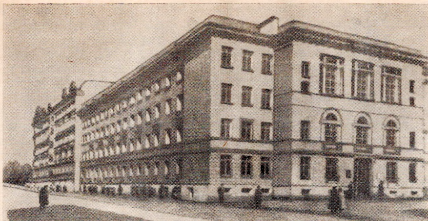
Рис. 97. Будынак школы, пакрыты воданепранікальнымі растворамі.
