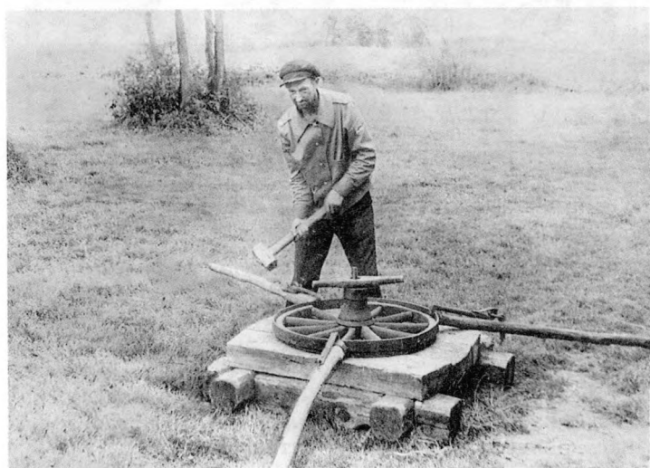
Стальмашнае рамяство (нацягванне шыны на кола). В. Сварынь Драгічынскага р-на
