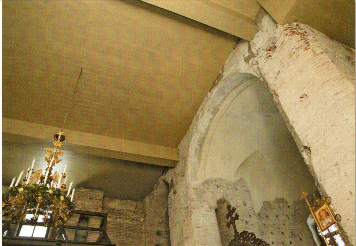
Абноўлены балкон хораў Обновленный балкон хоров Renovated choir balcony
