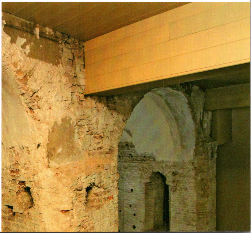
Новае сталае пакрыццё царквы Новое потолочное покрытие церкви New ceiling covering of the church
