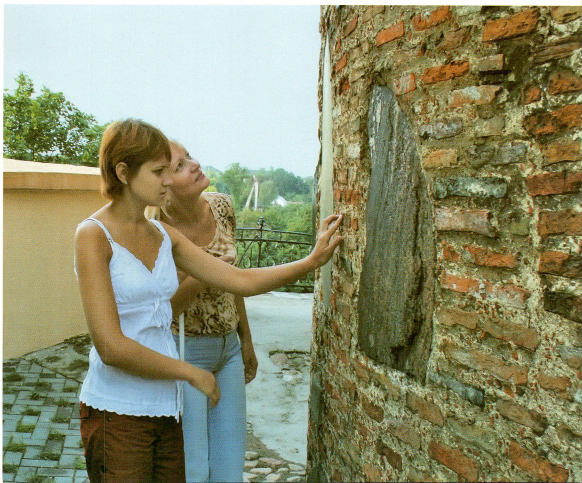
Шліфованія гранітныя камяні ў муры сцен Шлифованные гранитные камни в кладке стен Polished granite stones in the brickwork
