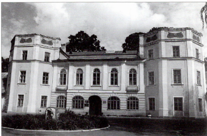
Будынак на Гарадніцы, узведзены для Медычнай акадэміі. Сучасны выгляд (вул. Ажэшкі, д. 20)
